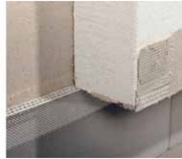
Remate de zócalo con perfiles de esquina con malla
