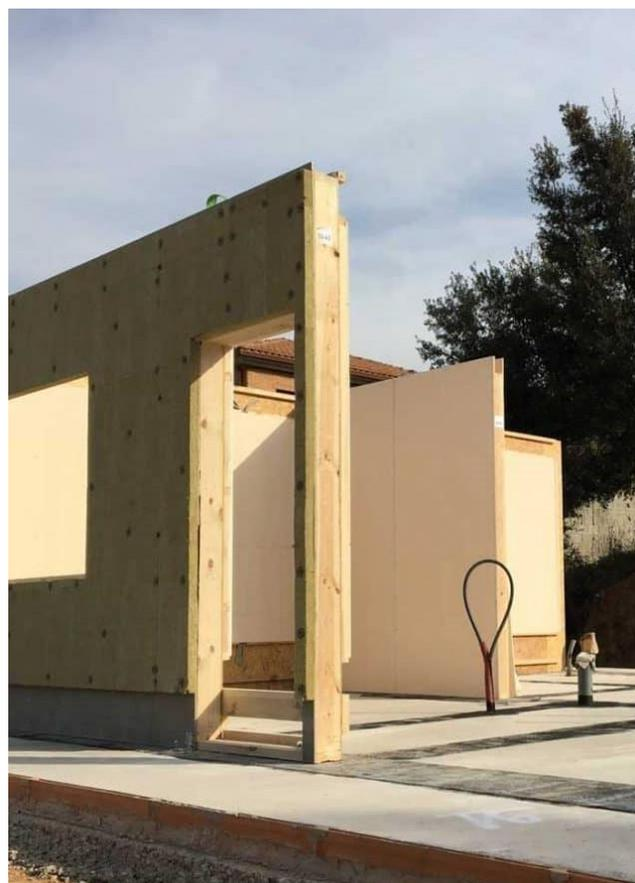
**Los paneles exteriores tienen un grosor de 28 cm**, lo que les capacita incluso para la construcción de casas pasivas.
