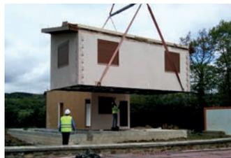
Se trata de **casas montadas en fábrica y transportadas en grandes volúmenes** hasta la ubicación definitiva. Dependiendo del tamaño final de la casa pueden ser uno o varios módulos. Los paramentos pueden ser tanto en madera vista como en otro tipo de recubrimientos.
