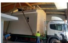
4. Una vez terminado y testado el proceso constructivo en fábrica, un puente grúa carga los módulos a un camión-plataforma.
