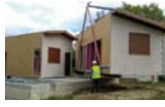
8. Los montadores se encargarán de colocarlos sobre la cimentación, calzarlos y posteriormente ensamblarlos al milímetro con el resto.
