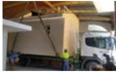
4. Una vez terminado y testado el proceso constructivo en fábrica, un puente grúa carga los módulos a un camión-plataforma.
